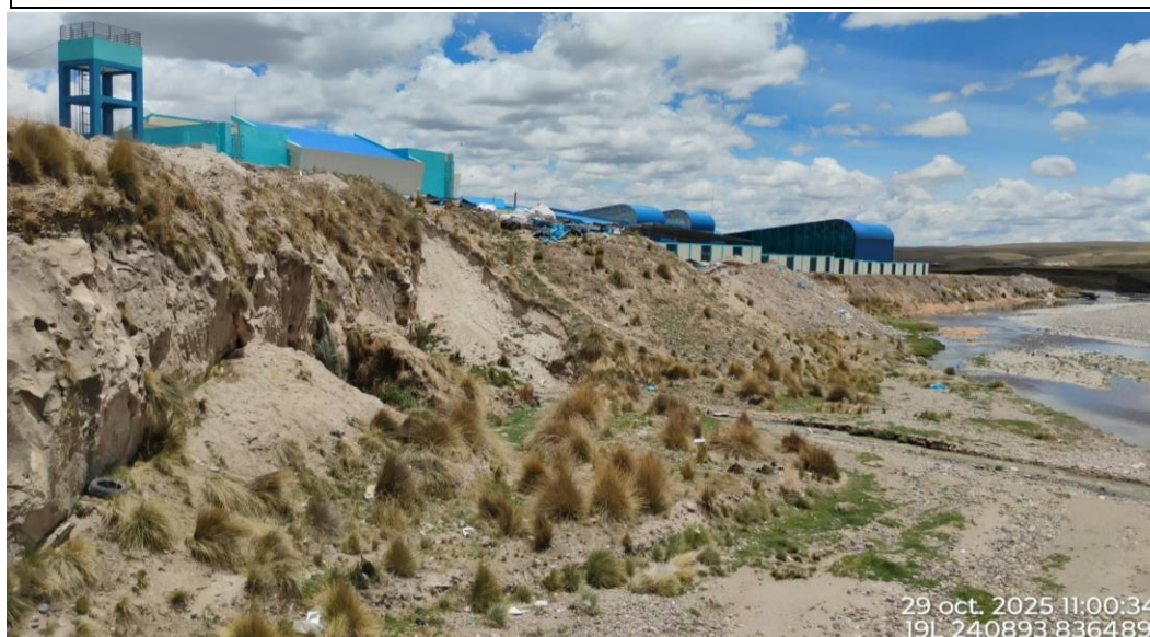
IMAGEN 04: EN LA MARGEN IZQUIERDA DEL RIO SE PRESENTA PUNTO CRÍTICO A EROSIÓN DEL TALUD QUE PUEDE AFECTAR EL COMPLEJO DEPORTIVO RECREACIONAL MOTOTAXISTAS
