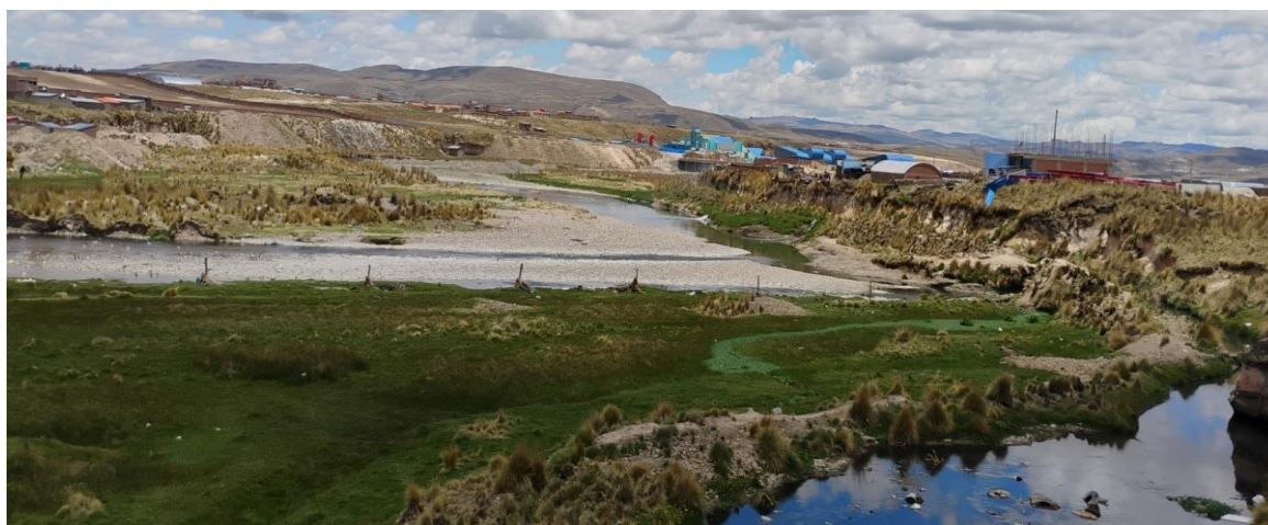
IMAGEN 03: MARGEN DERECHA PRESENTA EROSIÓN DEL TALUD QUE PUEDE AFECTAR A VIVIENDAS. EN LA MARGEN IZQUIERDA SE PRESENTA PLANICIE Y AREA DE INUNDACION QUE AFECTA A VIAS URBANAS EXISTENTES.
