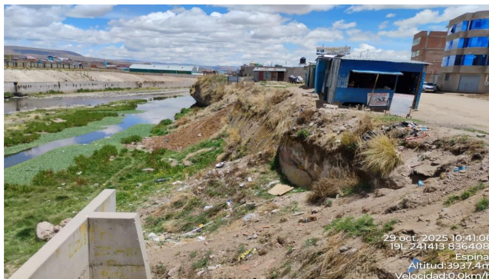
IMAGEN 01: EN LA MARGEN DERECHA DEL RIO CAÑIPÍ AGUAS ABAJO DEL PUENTE SAN MARTIN, VULNERABLE A EROSION LATERAL.
