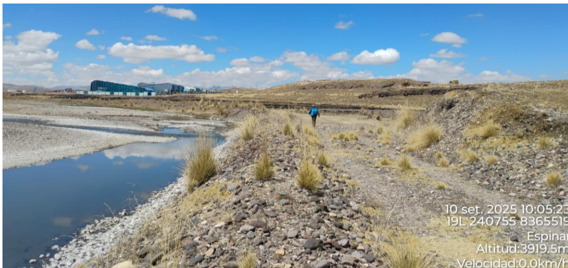
IMAGEN 05: EN LA MARGEN IZQUIERDA DEL RIO DEL RIO SE PRESENTA PUNTO CRÍTICO A EROSIÓN DEL TALUD E INUNDACION DE LAS AREAS ADYACENTES.
